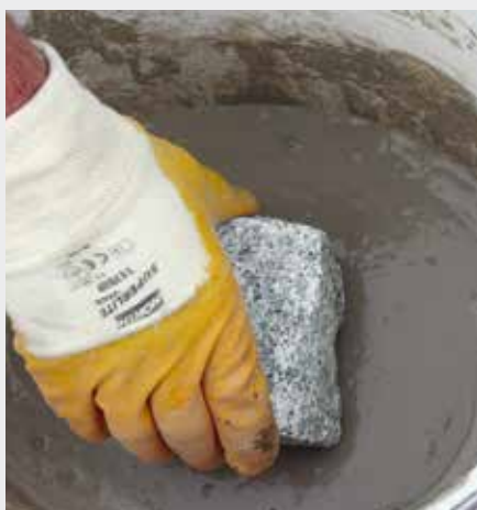
Belagelement in Haftschlämme eintauchen. Alternativ unterseitig einstreichen.
