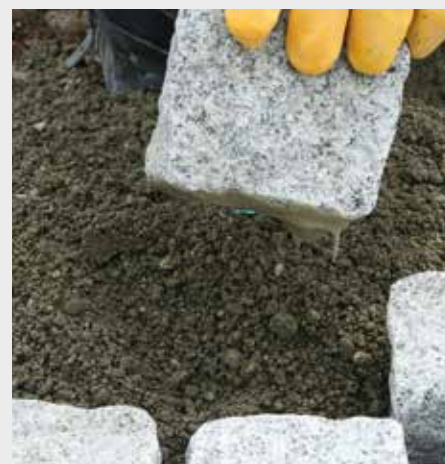
Belagelement hammerfest in den frischen Bettungsmörtel (z. B. tubag TPM-D4) versetzen.
