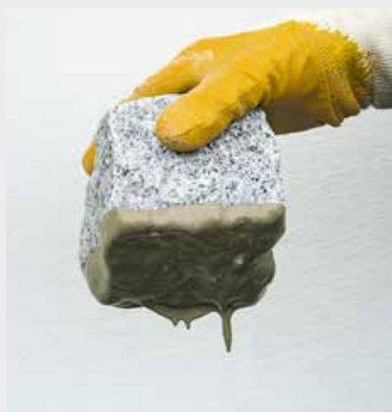
Belagelement satt mit Haftschlämme versehen.
