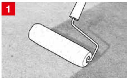
1 Der tragfähige Untergrund wird mit dem tubag DTG VarioRapid Dispersions-tiefengrund für saugende Untergründe grundiert und Randdämmstreifen werden angebracht
