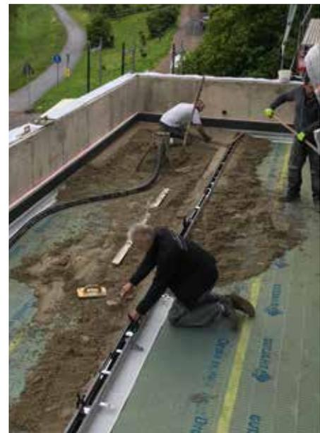
Die speziellen Rezepturen von tubag SteinPlus begünstigen eine schnelle Erhärtung, und die teilweise kristalline Wasserbindung ermöglicht die schnelle Einbindung von überschüssigem Anmachwasser. Darüber hinaus erfüllen tubag SteinPlus Produkte auch technische Anforderungen wie das Verhindern von Verformungen und Hohllagigkeiten, die ein hohes Maß an Mörtelkompetenz voraussetzen.
