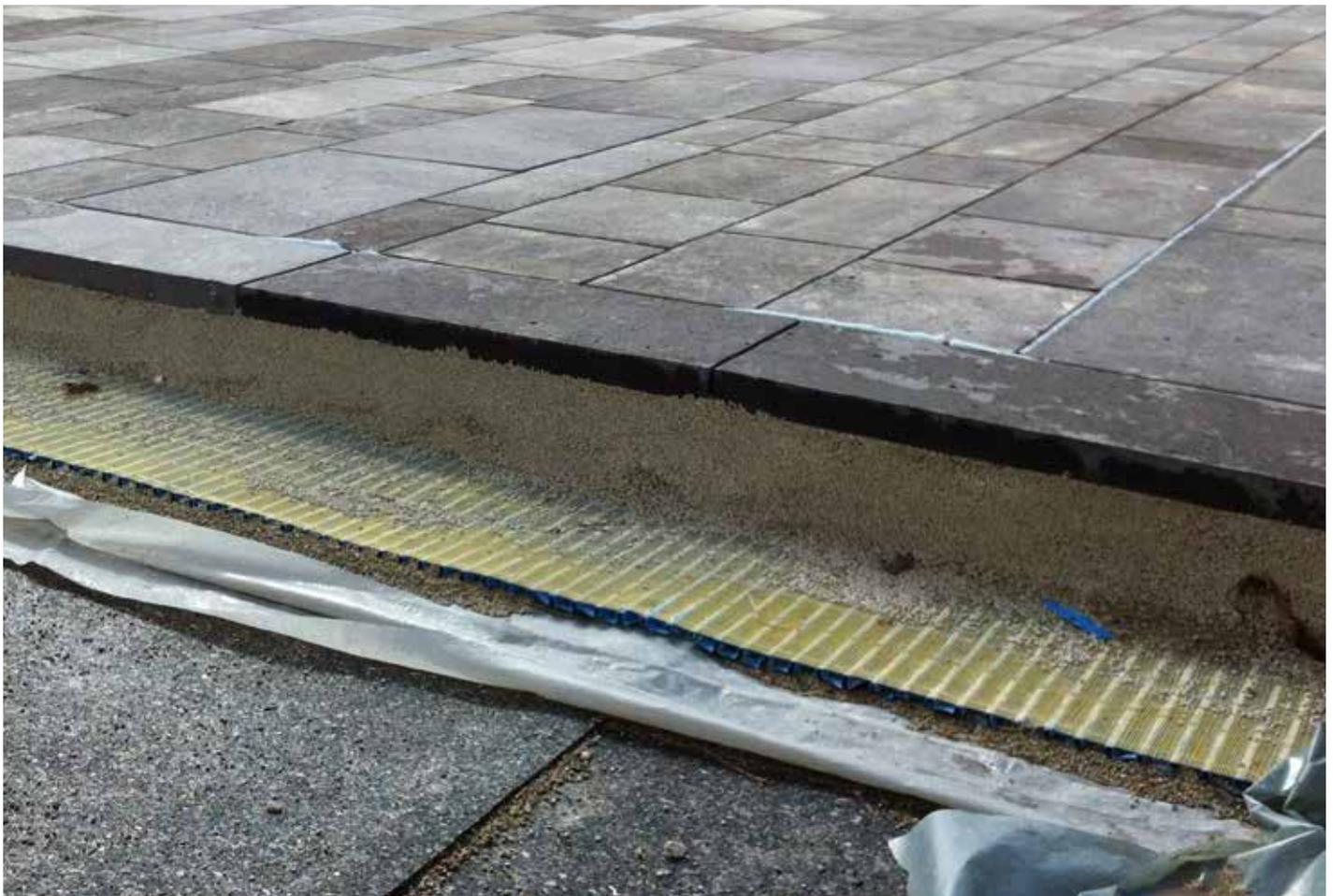
Durch die Verwendung von Drainagematten wird der Belag aufgestellt und kann schnell abtrocknen. Eindringendes Wasser wird schnell abgeführt und verursacht keine Frostschäden.
