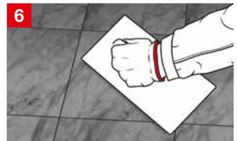
**6** Platten mit der entsprechenden Natursteinfuge tubag TNF VarioRapid ausfüllen
