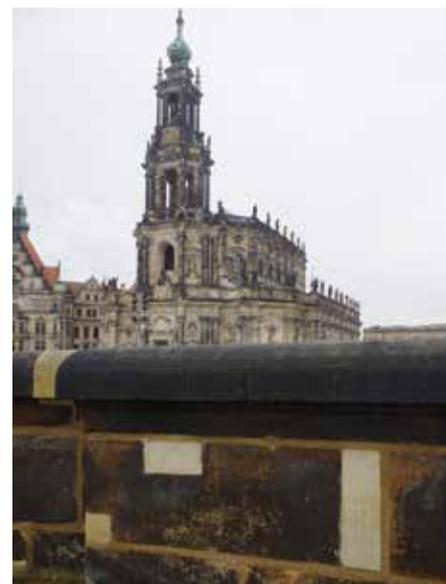
Bei dieser Brüstung mussten schadhafte Natursteine durch Ersatzstücke aus dem Ausgangsmaterial, sogenannte Vierungen, ersetzt werden. Spezielle Vierungskleber wie der tubag SEM-K können werkseitig eingefärbt werden, um Farbunregelmäßigkeiten zu reduzieren.
