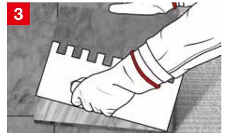
Auf der Rückseite des Belagelements wird eine Kratzspachtelung mit dem entsprechenden tubag Dünnbettmörtel aufgetragen
