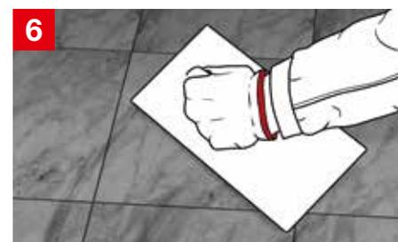
6 Abschließend werden die Platten mit der entsprechenden tubag Natursteinfuge ausgefugt
