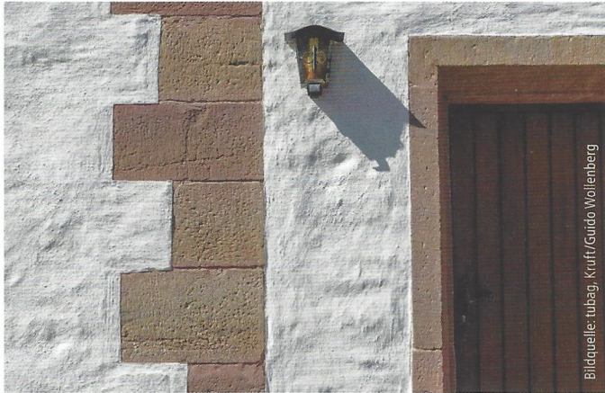
Abb. 10: Kolmerbergkapelle: Vor dem Schlämmen wurde der NHL-Putz auf die Wand geworfen und mit einer Bürste verstrichen. Anschließend wurde die Schlämme in einer groben und zwei feinen Schichten aufgetragen. Der dünne Schlamm auftrag lässt die strukturierten Putzflächen deutlich in Erscheinung treten. Beide Gebäude erhielten abschließend einen Sumpfkalkanstrich.
