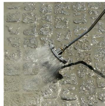
Pflasterfugenmörtel von der Oberfläche absprühen.
