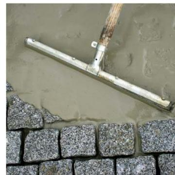
Den hochfließfähigen und selbstverdichtenden Fugenmörteln einbringen.
