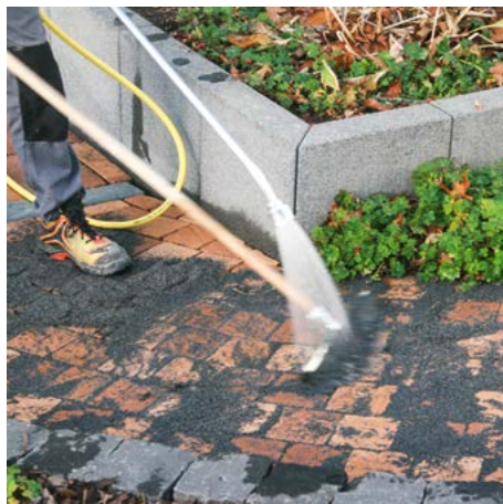
Der tubag Pflasterfugenmörtel PFF ProLine wird durch klassisches Einschlämmen eingebracht.
