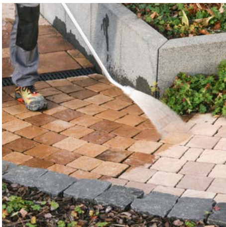
Der tubag Pflasterfugenmörtel PFF ProLine wird durch klassisches Einschlämmen eingebracht.
