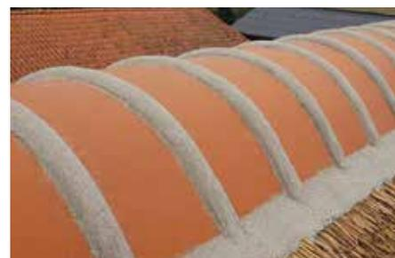
Firstabschluss mit FL-D Dachdeckermörtel auf einem reetgedeckten Dach
