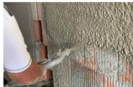
Auftrag eines FL-P Historischer Kalkputz mit der Putzmaschine
