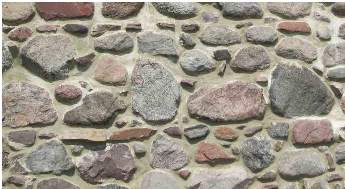
Mur kamienny murowany zaprawą NHL-M
