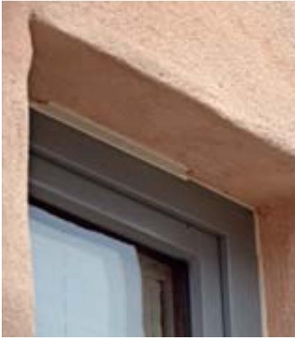
Seine Farbigkeit erhält der Kalkputz durch eine Kombination aus Ziegelmehl und rotem Eisenoxid.
