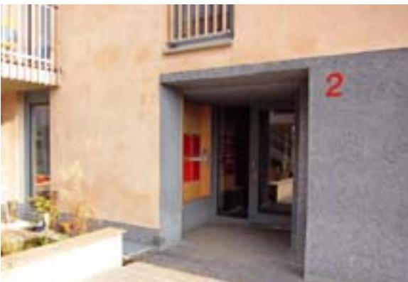
Der Sockelputz ist rund um den Eingang und die Fensterflächen des Cafés bis auf Geschosshöhe ausgeführt.
