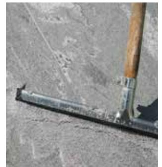
Der tubag Pflasterfugenmörtel PFK wird wie ein normaler Fugensand mit reichlich Wasser eingeschlämmt. Zusammen mit seiner feinen Körnung lassen sich dadurch Fugen ab 2 mm füllen.
