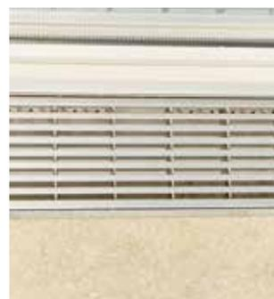
Bewegungsfuge zwischen Entwässerungsrinne und Belag. Durch das Abstreuen mit Quarzsand lässt sich die Oberfläche farblich und strukturell anpassen.
