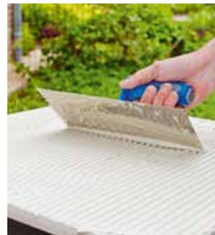
Für einen optimalen Verbund zwischen Keramikelement und Bettungsmörtel wird die tubag Trass Haftschlämme TNH-flex mit einer 6 mm Zahnkelle aufgebracht.
