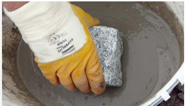
Die tubag TNH rapid Haftschlämme wird direkt vor dem Einbau auf die Unterseite des Pflastersteins oder der Platte aufgetragen. Bei bestimmten Konstruktionen kann die Haftschlämme auf die Bettung aufgespritzt werden.
